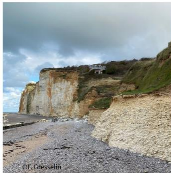
Erosion de la falaise à Saint-Pierre-en-Port (76)
