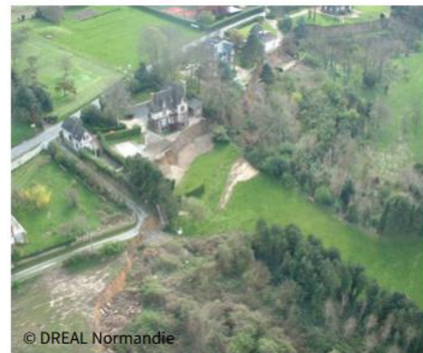
Glissement de terrain littoral à Trouville-sur-Mer (14)
